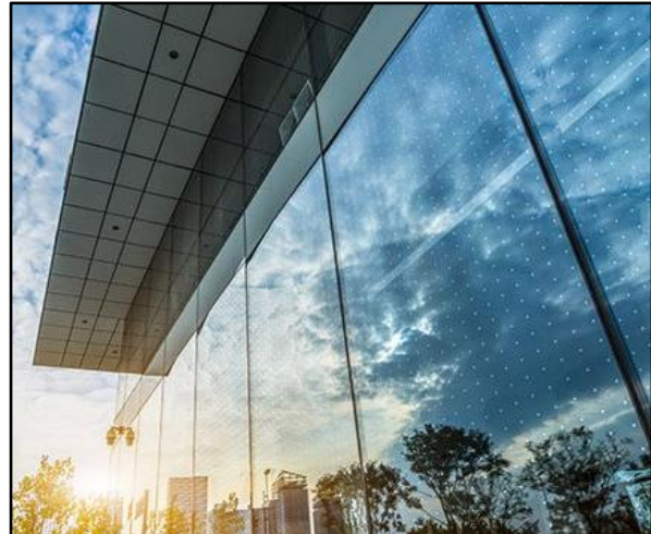
Abb. 12: Glasfassade mit Punktmuster, Quelle: SEEN AG
