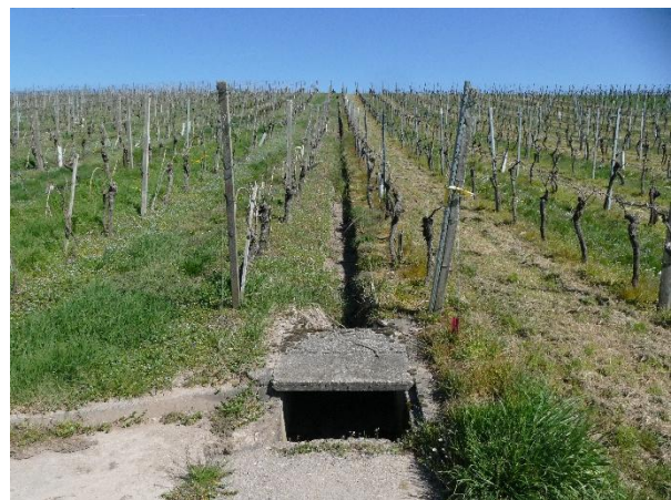
Abb. 3: Blick nach Nordosten auf Betonrinne auf Flst.-Nr. 4557
