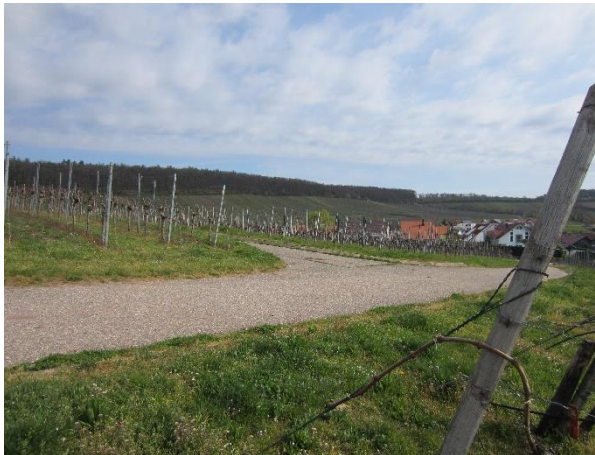
Abb. 2: Asphaltweg im Plangebiet
