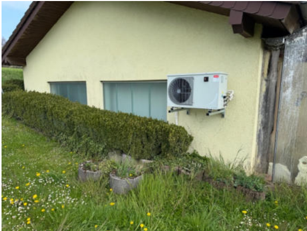
Abb. 6: Bestandsgebäude am Affaltracher Weg mit Pflanzkübeln und Buchs.
