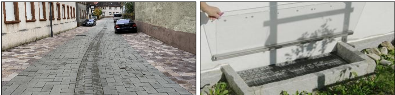
Abbildung 11: Umsetzungsbeispiel wassersensible Straße mit negativem Dachprofil (links) sowie Umsetzungsbeispiel Lichtschachtaufkantung mit Überdeckung 3 (rechts)
