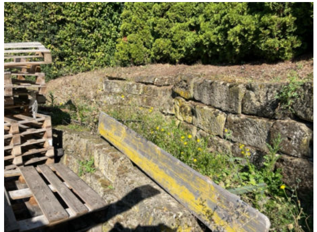
Abb. 19: Trockenmauer zwischen kleiner Freifläche und Strauchgruppe.
