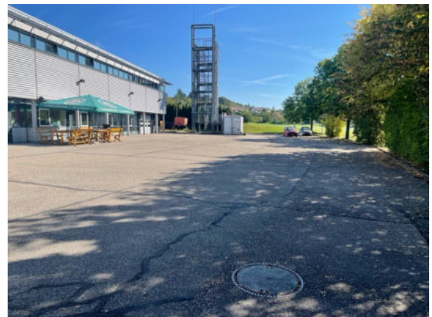
Abb. 11: Übungsturm südöstlich des Bestandsgebäudes ohne Hinweise auf eine tierische Nutzung.
