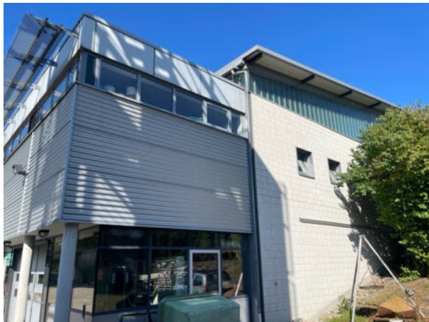
Abb. 4: Ostseite des zweigeteilten Bestandsgebäudes aus südöstlicher Richtung.
