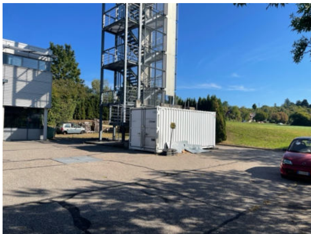
Abb. 10: Übungsturm südöstlich des Bestandsgebäudes ohne Hinweise auf eine tierische Nutzung.
