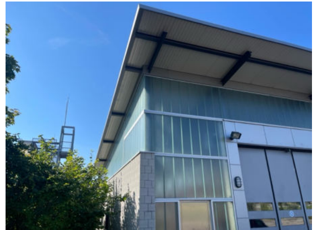
Abb. 9: Blick aus Nordosten auf das Dach und die Außenwand des nördlichen Gebäudeteils.
