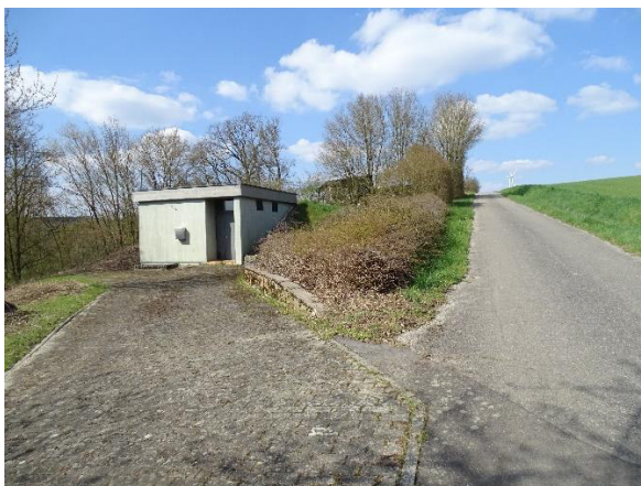
Abb. 7: Kleine Hütte und Gehölze westlich des Plangebiets
