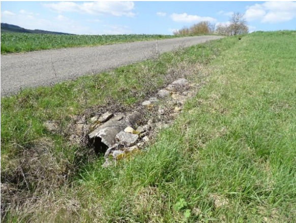
Abb. 9: Rohrdurchlass im Südwesten
